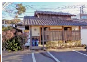
▲北斎公園トイレ(外)
