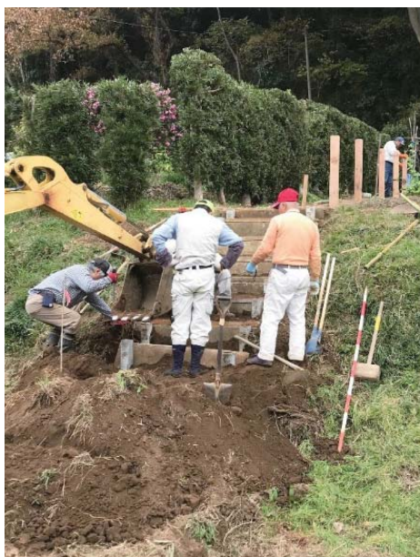
【階段設置作業の様子】
