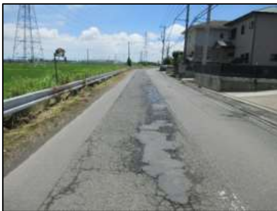
写真-1 路面被害状況
