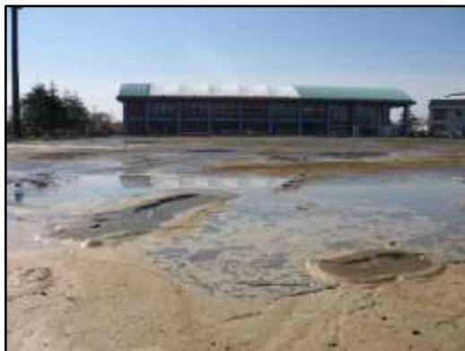
写真-2 日の出中学校液状化被害状況
