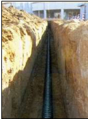
写真-5 暗渠敷設状況の写真
