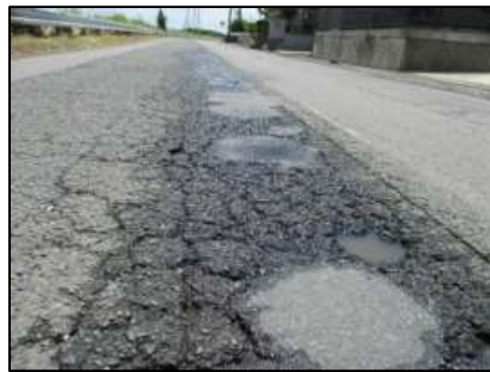
写真-1 路面被害状況
