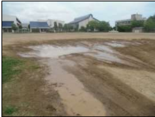
写真-1 日の出小学校液状化被害状況
