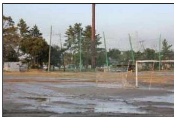
写真-2 日の出中学校液状化被害状況
