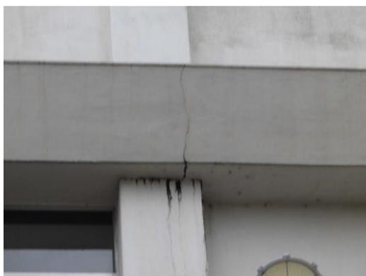
写真1 市役所本庁舎 外壁の亀裂
