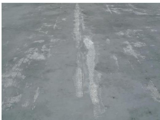
写真1 旧牛堀出張所 防水シートの損傷
