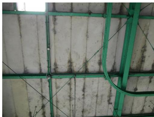
写真2 クリーンセンター ALCからの雨漏り
