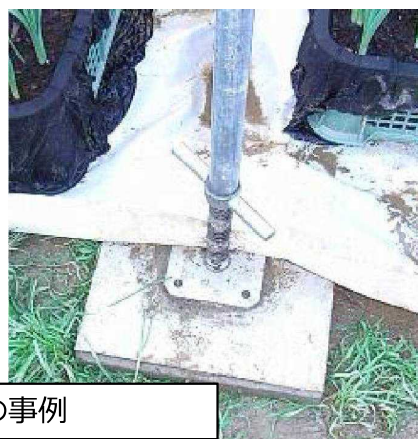
図一24 ハウスの雪害対策（福井県雪害対策マニュアル）
