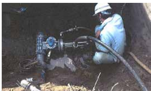
上水道布設工事
