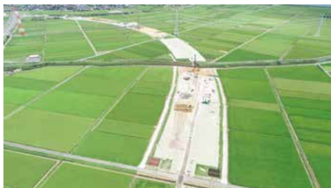
東関東自動車道水戸線建設状況
