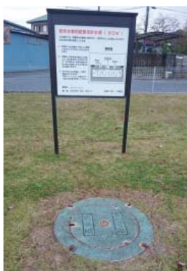
耐震性貯水槽
