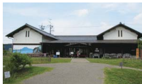
解体されたふるさと館
