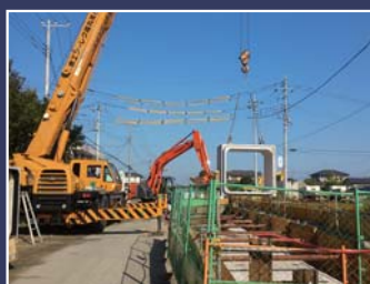
目の出地区液状化対策事業
