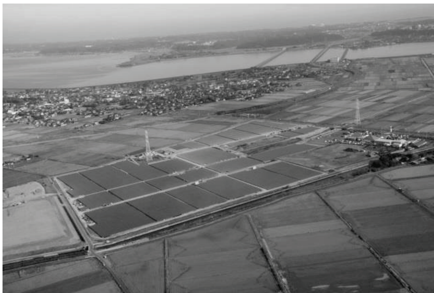
水郷潮来ソーラー発電所
