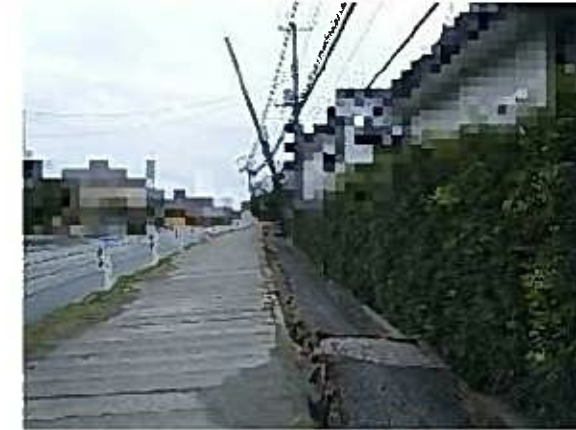
写真 1.4-12 雨水排水路の被害状況(2)
