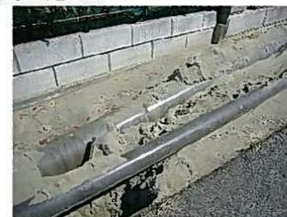
写真 1.4-32 汚水管の浮上り(2)
