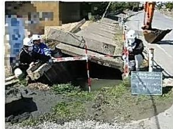
写真 1.4-13 雨水排水路の被害状況(矢板の抜上り)
