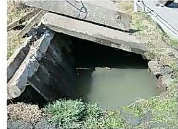
写真 1.4-13 雨水排水路の被害状況(矢板の抜上り)
