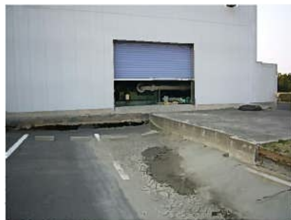
写真 1. 4-15 建物の基礎地盤の沈下(1)
