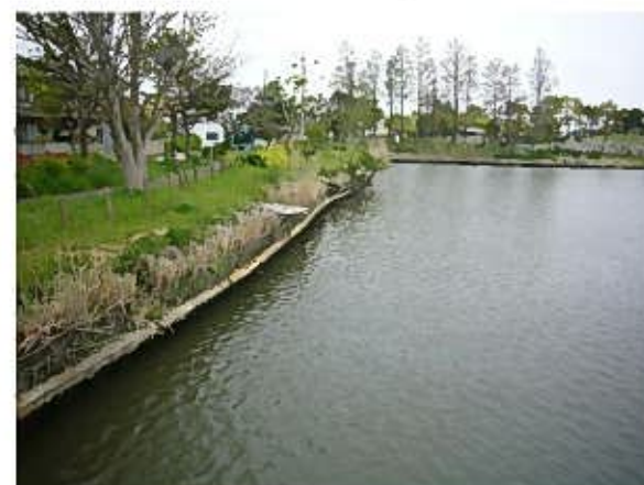
写真 1. 4-23 三角池の被害状況(矢板護岸)
