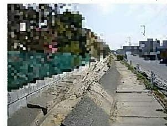
写真 1.4-31 汚水管の浮上り(1)
