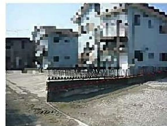
写真 1.4-29 フェンスの抜上り
