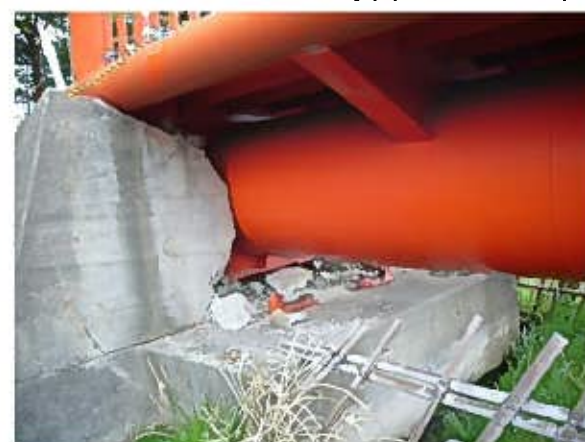
写真 1. 4-22 ひょうたん池の被害状況(橋台)
