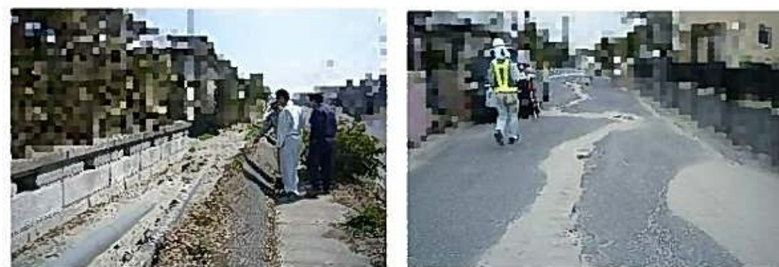
汚水管の浮上
