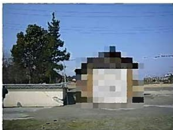
写真 1.14-24 お寺の塀の被害状況(液状化による塀の沈下とクラック)
