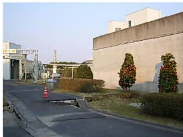
写真 1. 4-16 建物の基礎地盤の沈下(2)
