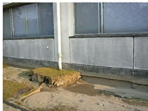
写真 1. 4-16 建物の基礎地盤の沈下(2)
