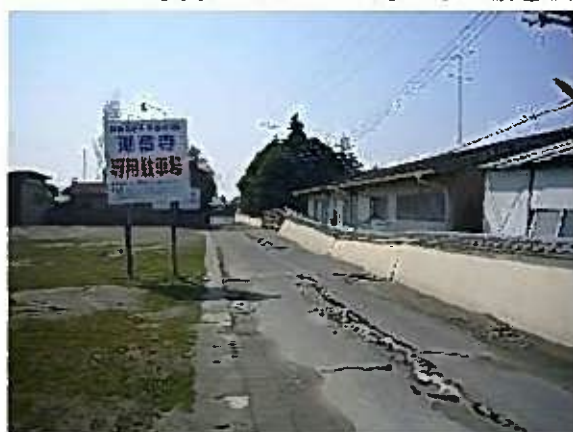
写真 1.4-25 お寺の塀の被害状況(液状化による塀の沈下)
