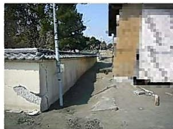
写真 1.14-24 お寺の塀の被害状況(液状化による塀の沈下とクラック)
