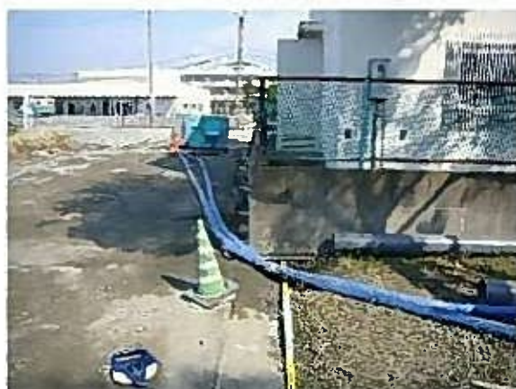
写真 1.4-27 側方流動による側溝の移動
