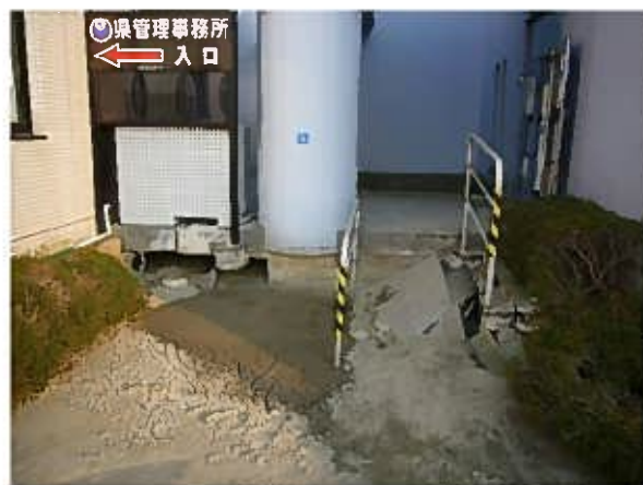
写真 1. 4-15 建物の基礎地盤の沈下(1)
