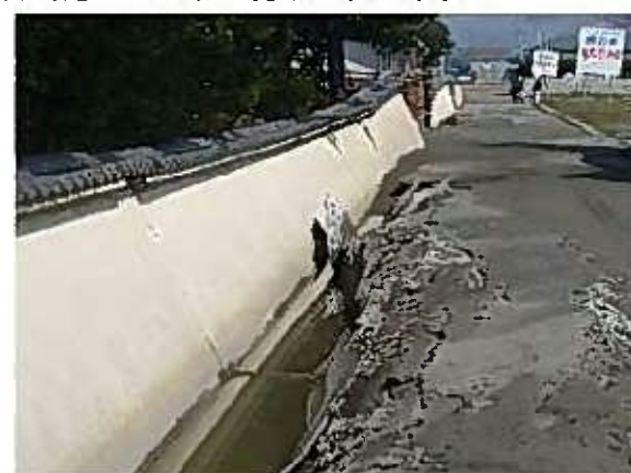
写真 1.4-25 お寺の塀の被害状況(液状化による塀の沈下)
