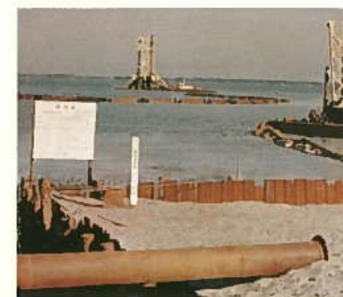
図 1.1-2 浚渫船による浚渫工事の様子 潮来町浪逆土地区画整理組合事務局（1978）：『新天地の創成』より引用図
