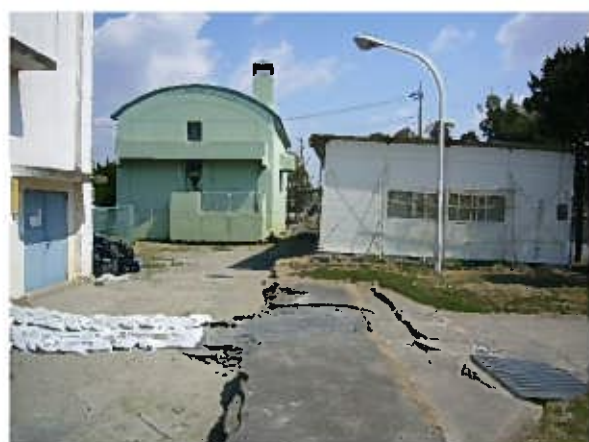
写真 1. 4-17 建物の基礎地盤の沈下とボックスカルバートの浮上り
