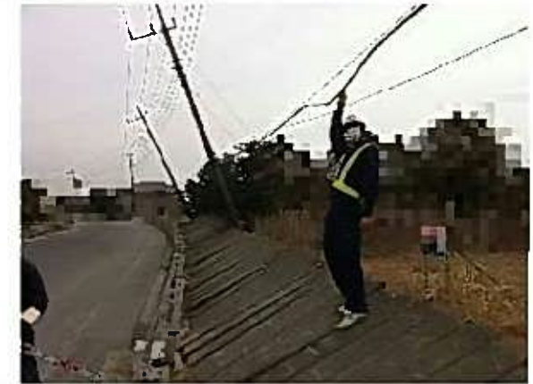
写真 1.4-12 雨水排水路の被害状況(2)
