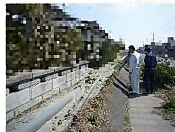
写真 1.4-32 汚水管の浮上り(2)
