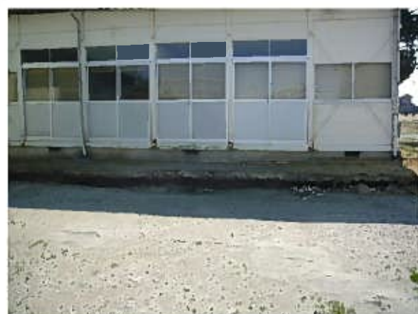
写真 1. 4-17 建物の基礎地盤の沈下とボックスカルバートの浮上り
