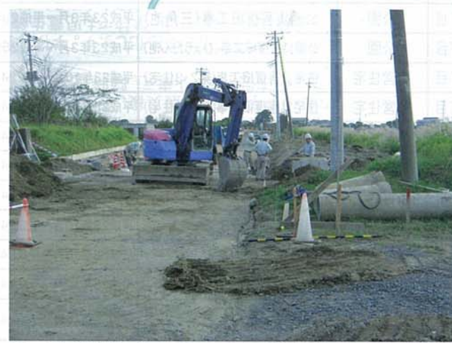
46 道路災害復旧工事【大洲閘門付近】
