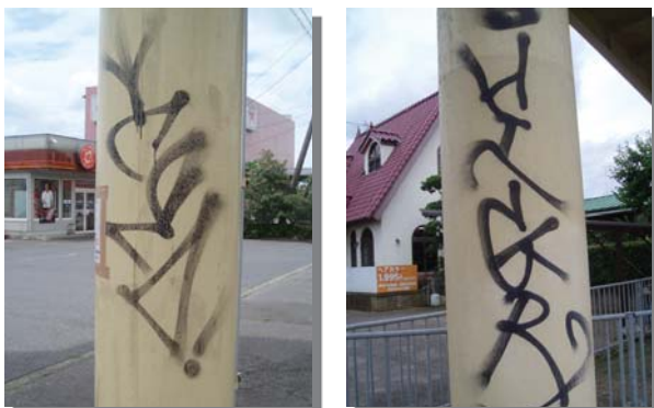
歩道橋への落書
