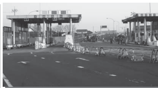
撤去工事中の料金所
