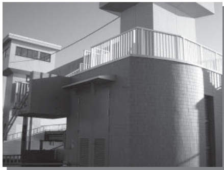
前川排水施設の展望デッキ
