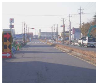
日の出地区道路改良工事
