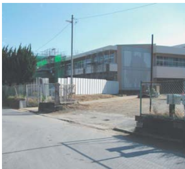
潮来二中外構工事
