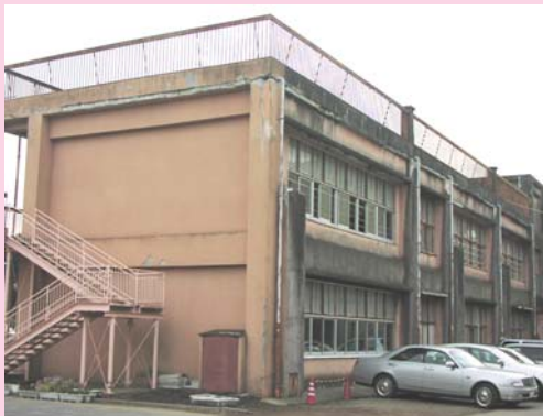
建て替え予定の延方小学校特別教室棟
