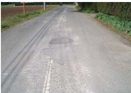
補修された道路
