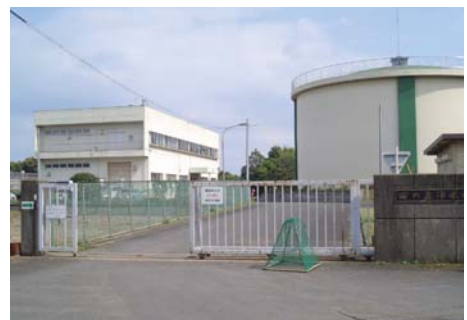
田の森浄水場
