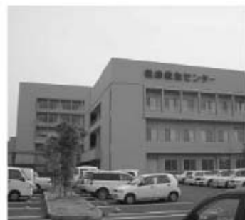
なめがた総合病院 救命救急センター
