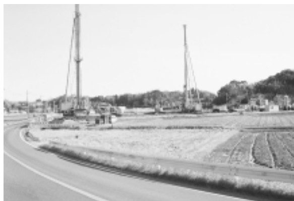
工事中の国道355号バイパス
