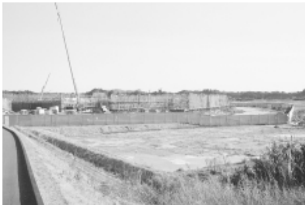
建設中の牛堀統合小学校
