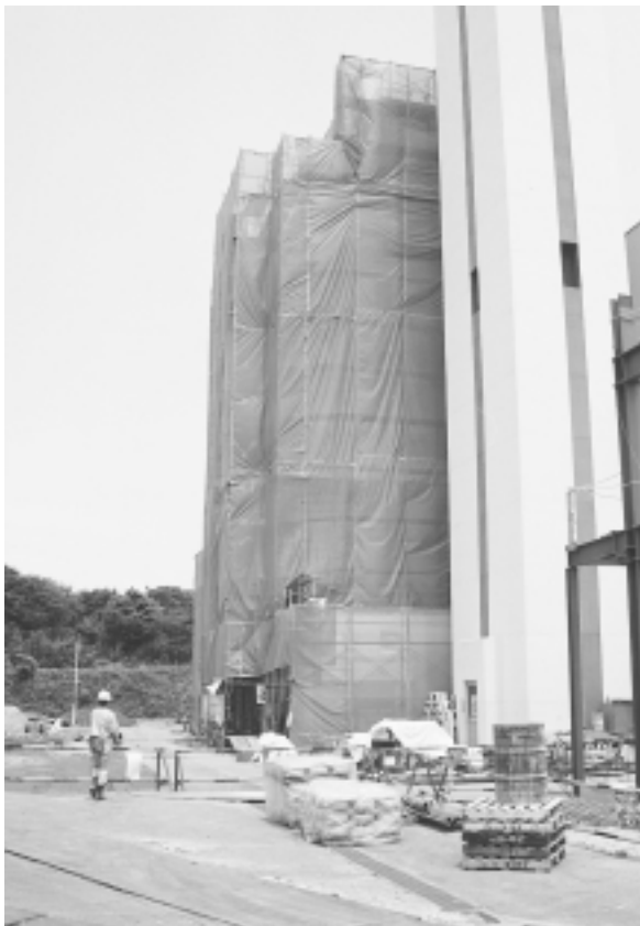
ダイオキシン対策工事
