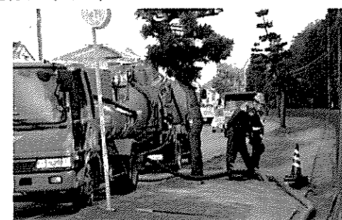
【公共下水道に詰まった汚物除去】
