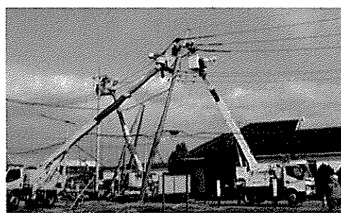
【電気の復旧工事】
