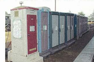
【仮設トイレ設置】
