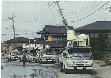
【電気の復旧作業】
