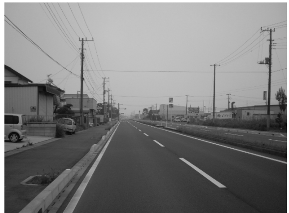
日の出地区の幹線道路となっている浪逆内洲線
