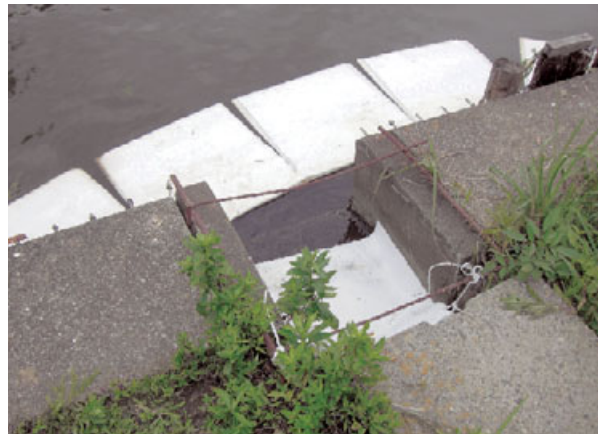
水質事故の際に発生源に設置した吸着マット
