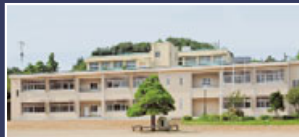
延方小学校特別教室棟改築事業
