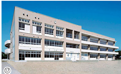
▲第1期工事が完了した潮来第二中学校校舎
