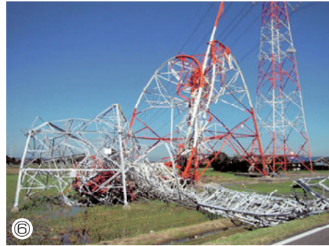
▲台風21号により鉄塔倒壊
