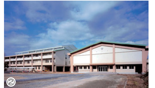
▲潮来第一中学校校舍・屋内運動場等完成
