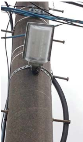
交換されたLED防犯灯
