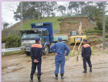
市長、議長らも被害現場を視察
