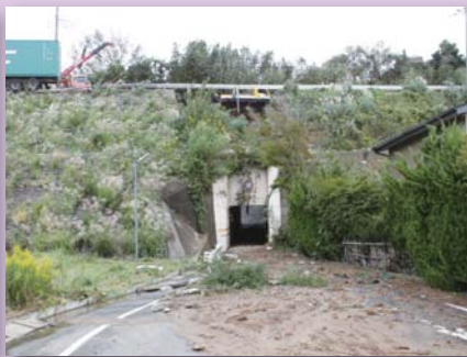
土砂が民家に流入
