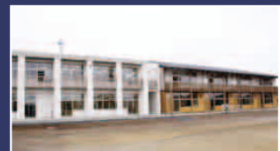
潮来小学校改築工事
