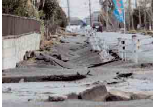
地盤沈下した歩道
