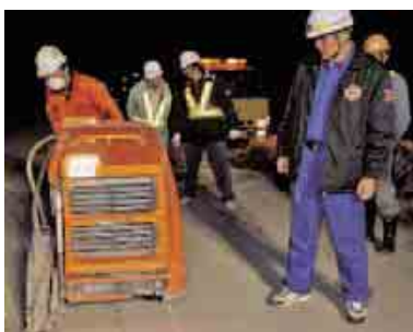
下水道の夜間復旧工事
