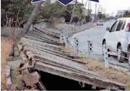
隆起した歩道（排水溝の蓋）
