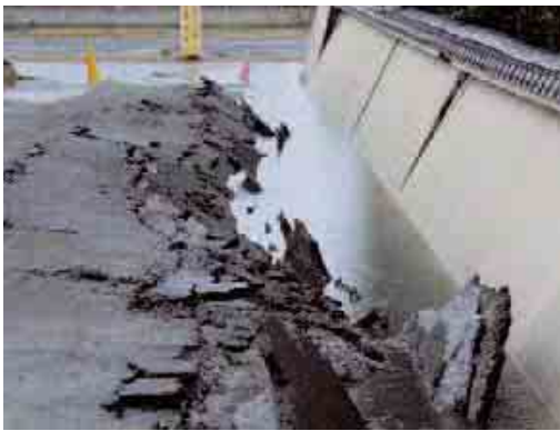
液状化による地盤沈下とふき出た水
