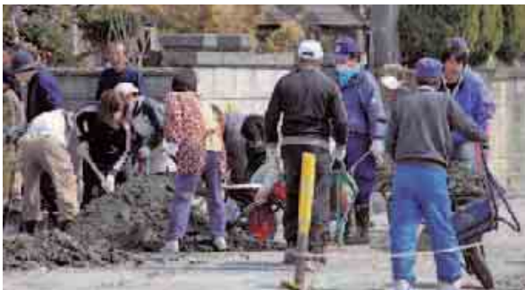
地域住民による土砂の撤去
