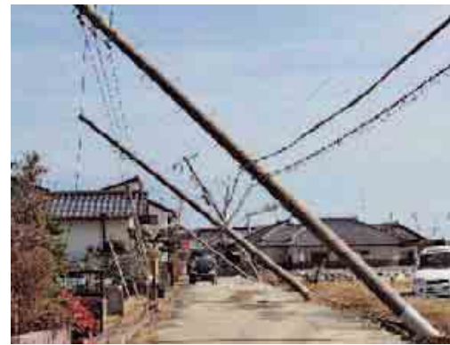
大きく傾いた電信柱
