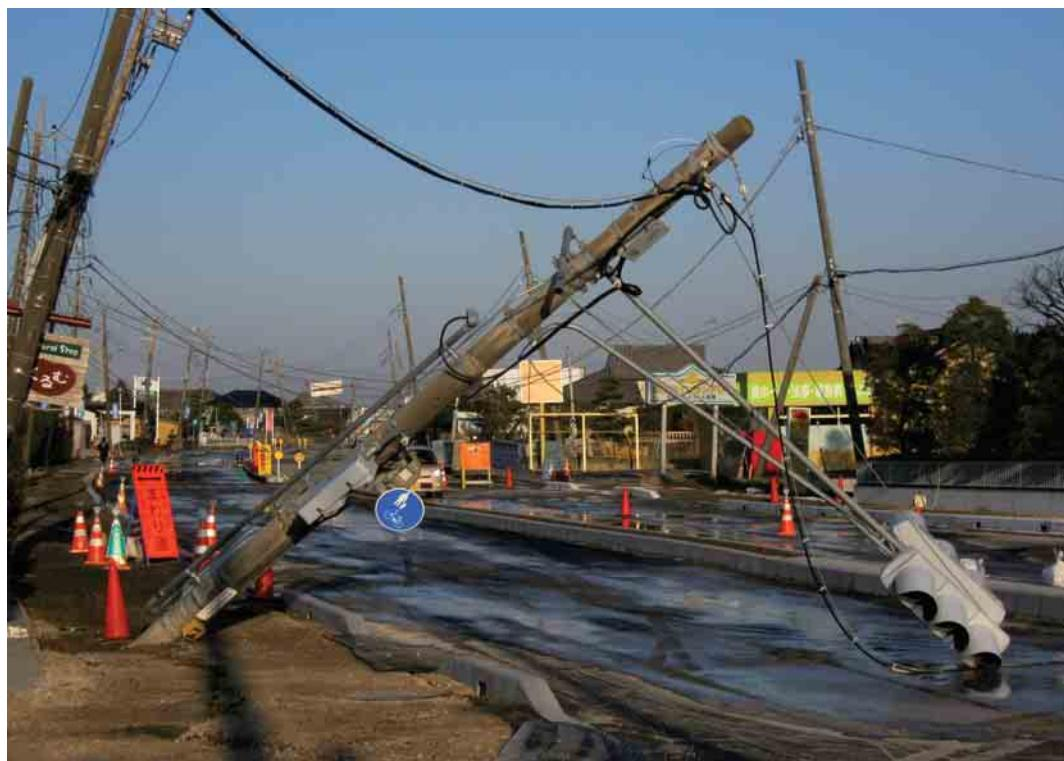
液状化による信号機倒壊（日の出7丁目）
