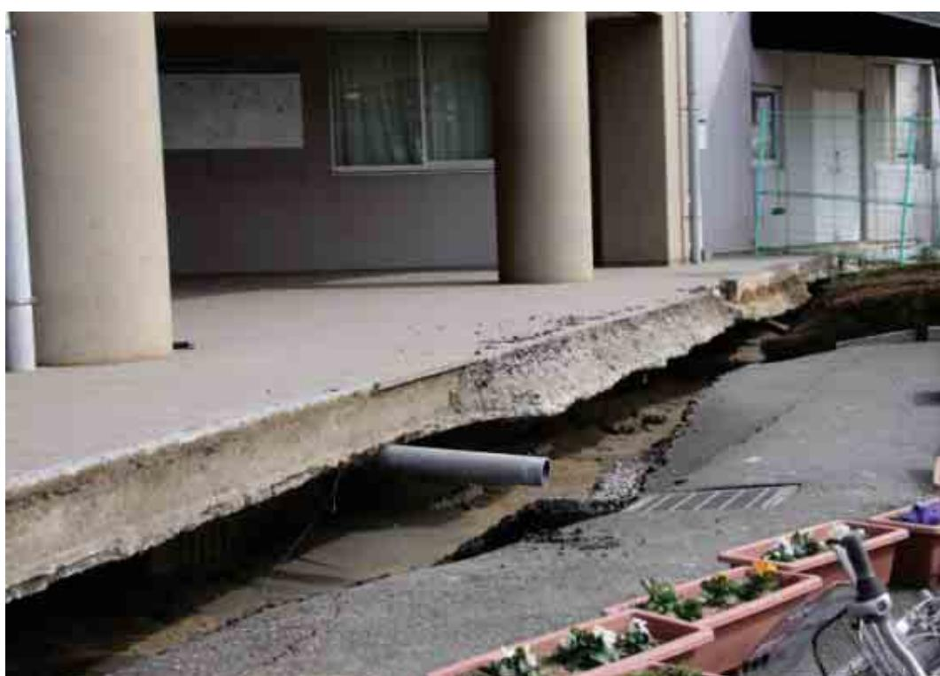
地盤沈下により基礎がむき出しになった日の出中学校校舎
