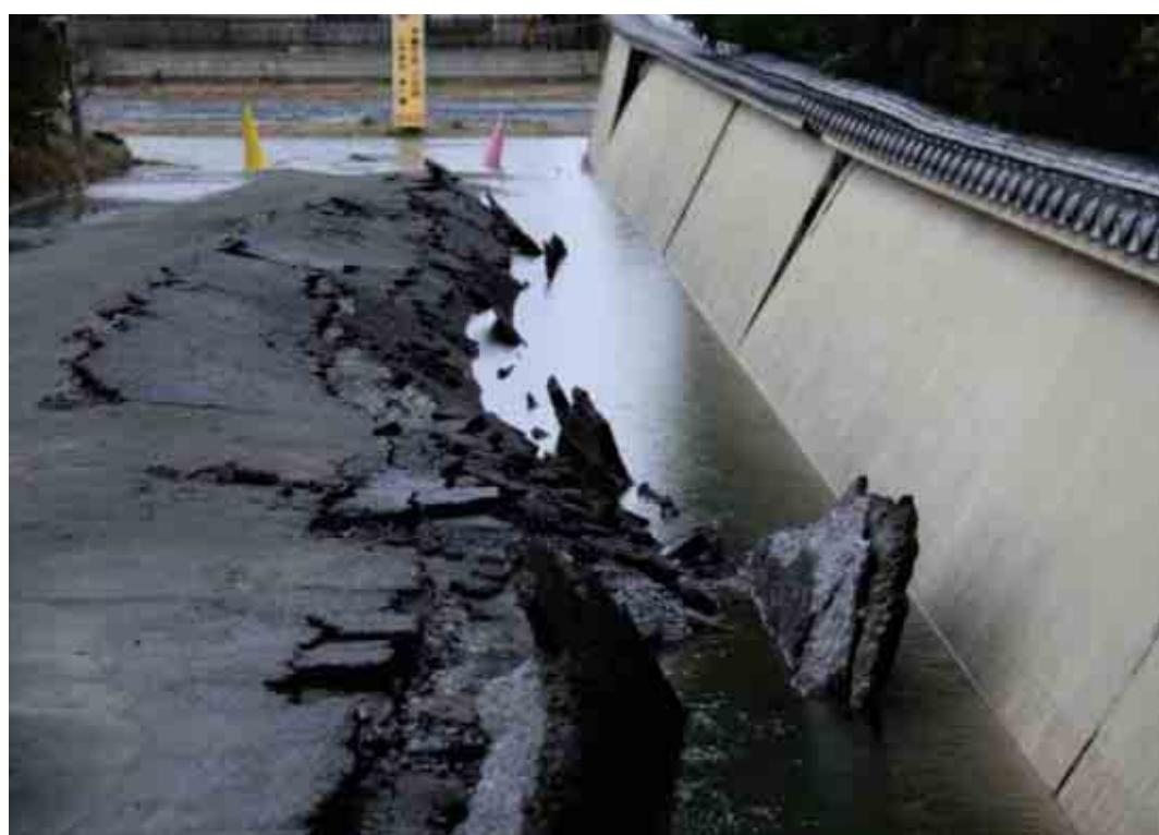
液状化によるコンクリート塀倒壊・道路隆起（日の出4丁目（潮音寺東側））
