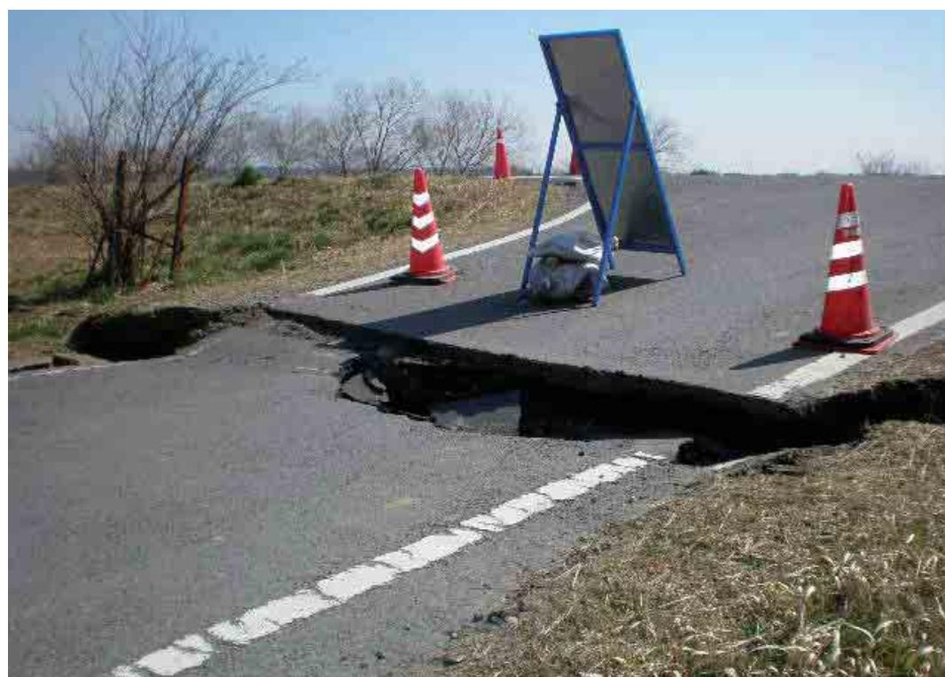
路面の陥没
