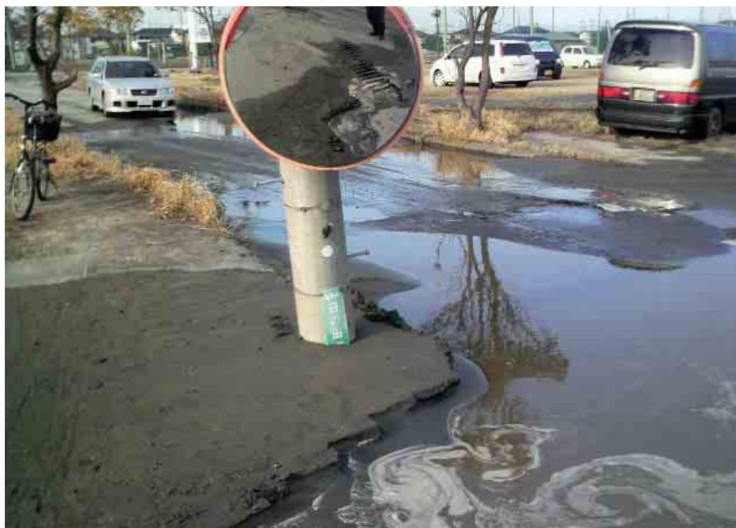
液状化により沈下した電柱
