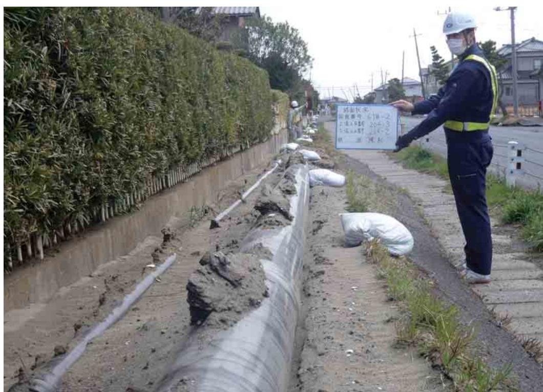
液状化による下水道管・水道管浮上 (日の出6丁目(南側1級12号線))
