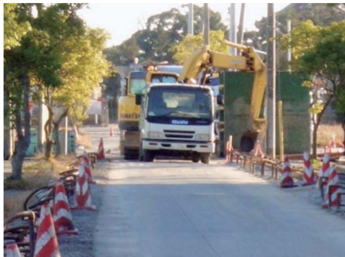
市内各地で復旧工事が行われています
