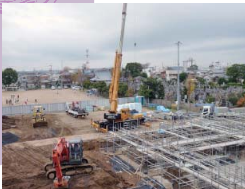
建設中の潮来小学校
