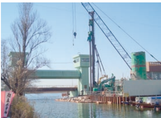
工事中の前川排水機場
