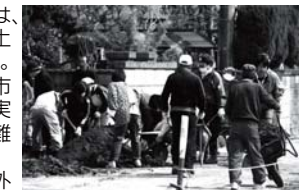
【地域住民による土砂の撤去作業】
