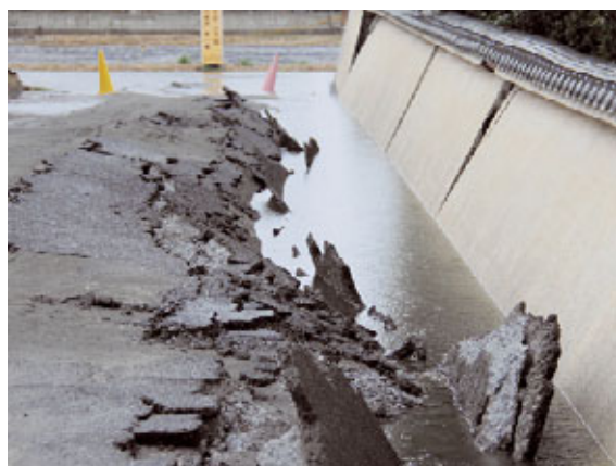
液状化による地盤沈下とふき出た水
