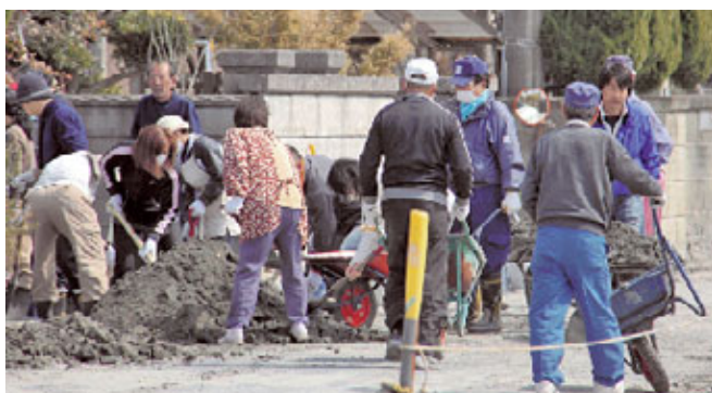
地域住民による土砂の撤去
