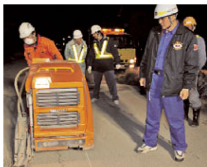
下水道の夜間復旧工事
