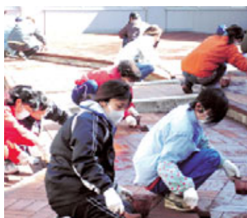
中庭の補修作業
