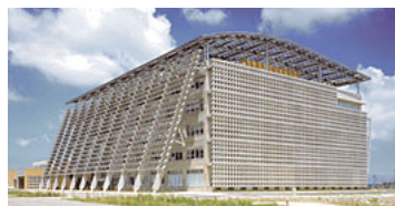
糸満市役所の屋根・壁面に設置された太陽電池
