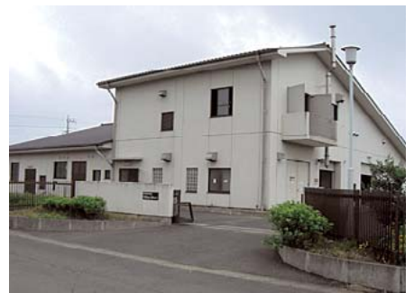
大生原浄化センター
